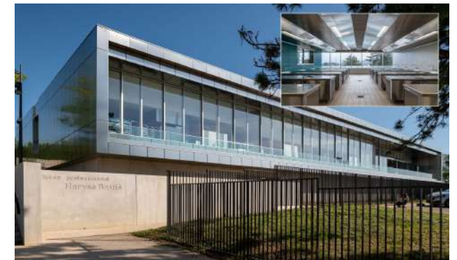
Training Centre Maryse Bastié, Hayange - France, rey-de crécy atelier d'architecture © Valérie Trégan
