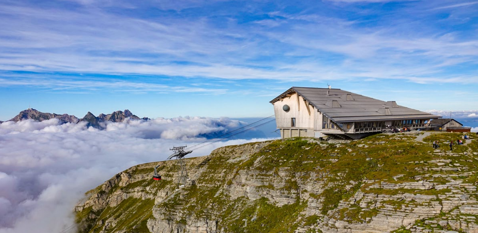
Chaeserrugg Mountain Station | Toggenburg, Switzerland | Herzog & de Meuron, Basel – Zinc work: Buehler Bedachungen und Bauspenglerer AG, Romanshorn | Uginox Patina K41
